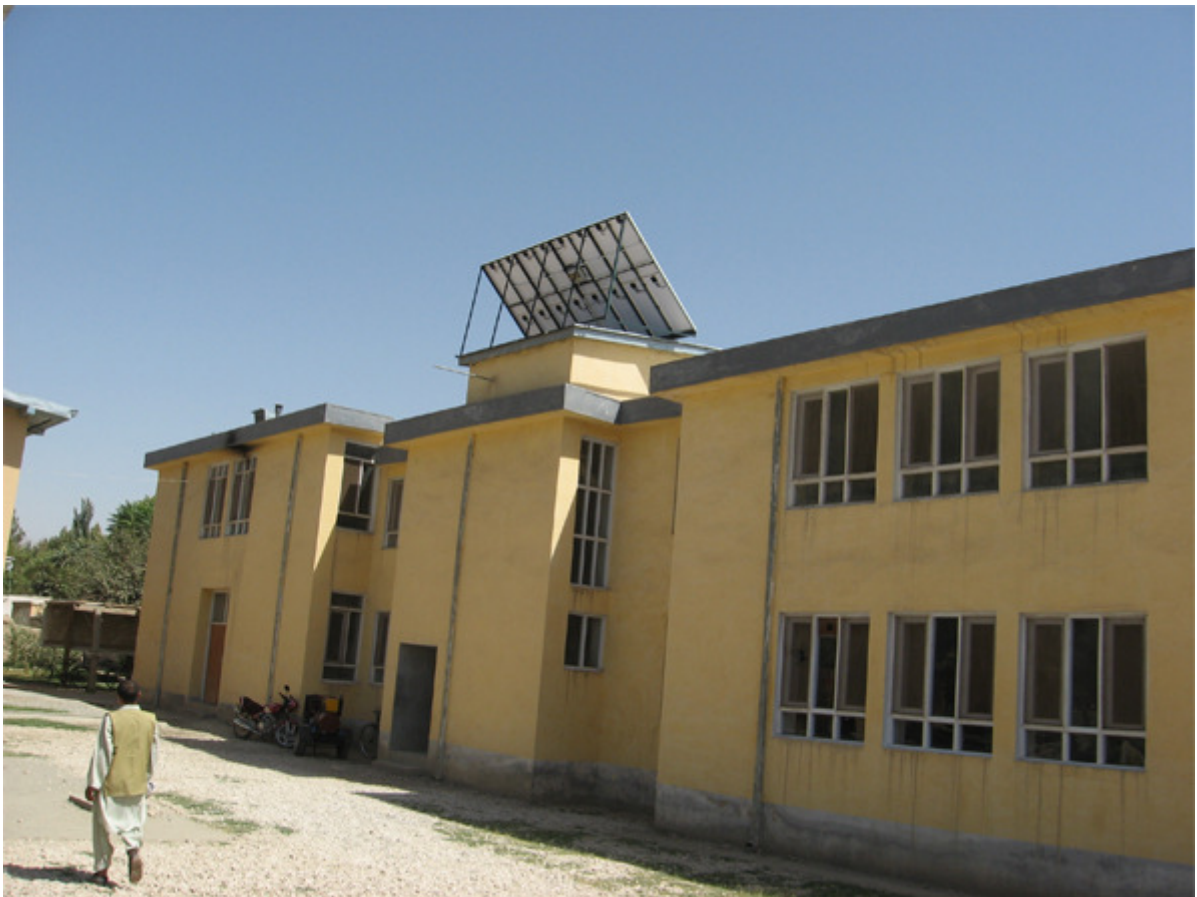
Die fertig gestellte Solaranlage mit 16 Module zu je 80 Watt Leistung installiert auf dem Dach des Teacher-Training-Colleges in Taloqan, Afghanistan
